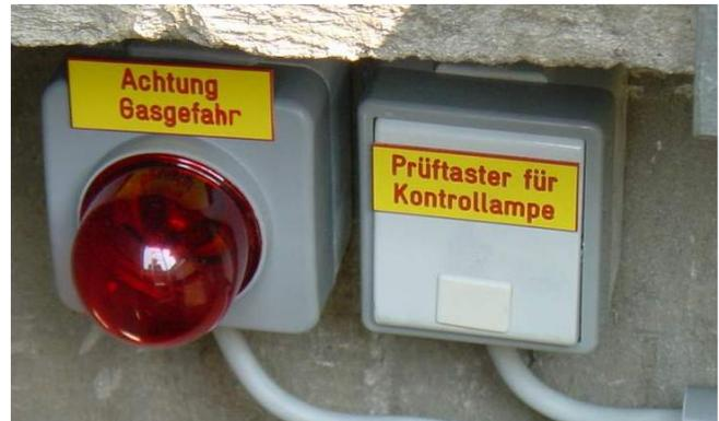
Bei neu errichteten Anlagen wurde zusätzlich ein Schalter zum Quittieren von Störungen eingebaut. Steht die Störung (bzw. der Alarm) nach dem Quittieren wieder an, so darf die Anlage auf keinen Fall betreten werden! Der zuvor beschriebene Ablauf („Überprüfen Gasmessgerät“) ist auch bei diesen Anlagen unbedingt durchzuführen!
